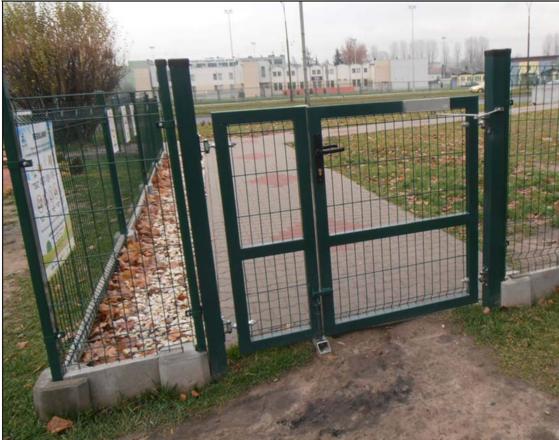
Fot.3 Projektowana furka dwuskrzydłowa. Po prawej stronie widoczny samozamykacz.
